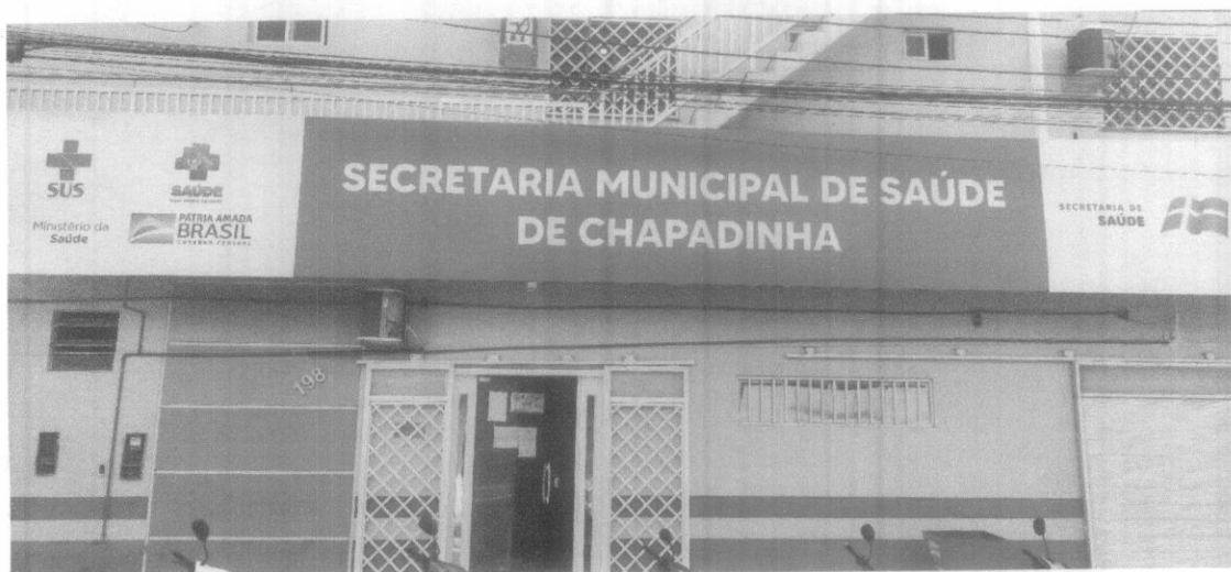
SECRETARIA DE SAÚDE, TRAVESSA SARAIVA, Nº 198, BAIRRO: CENTRO
